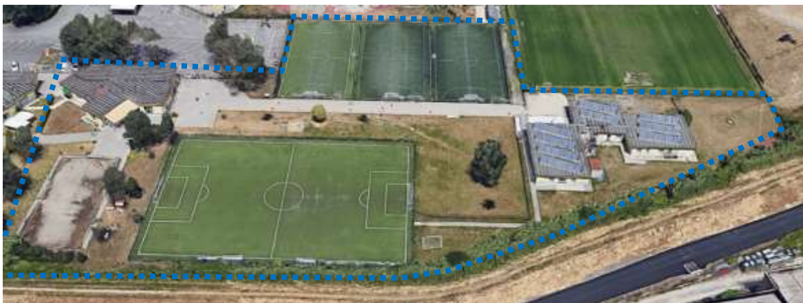
Fig.30: INQUADRAMENTO DI DETTAGLIO - SU CARTOGRAFIA 3D - DEL LOTTO IN VALUTAZIONE (FONTE: INTERNA).
